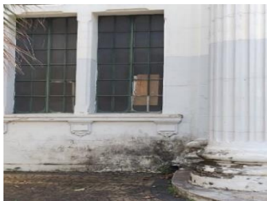
Figura 5. Patinas próxima a saída de água (acervo pessoal)
